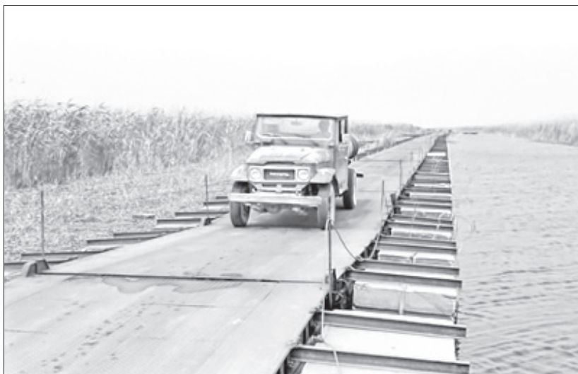
مزیت پل خیبری که مابین جزیره شمالی مجنون و ساحل هورالهیزه نصب شد این بود که با بالا و پایین رفتن آب هور، پل هم بالا و پایین می‌رفت.
