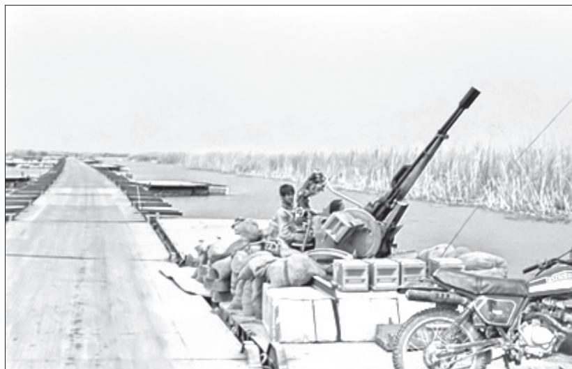
دستور ساخت و نصب پل شناور خیبری به طول ۱۴ کیلومتر روی آبهای هور به عنوان یکی از مهم‌ترین ابتکارات مهندسی جهاد سازندگی، فقط ۷۲ روز قبل از عملیات صادر شد.
