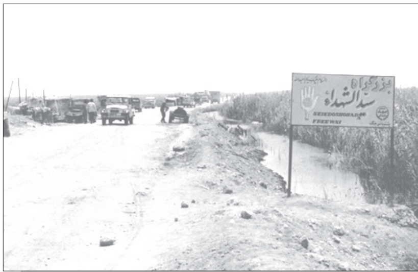
احداث جاده سیدالشهدا (ع) از قبل مدنظر فرماندهان نبود و با خلاقیت مهندسی جنگ جهاد سازندگی انجام شد و با احداث آن امکان تردد و پشتیبانی از خطوط مقدم یگان‌های خودی فراهم گردید.
