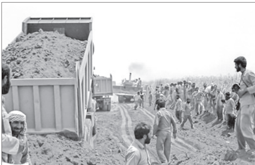
— احداث جاده سیدالشهدا (ع) از سه راه فتح تا جزیره مجنون شمالی
